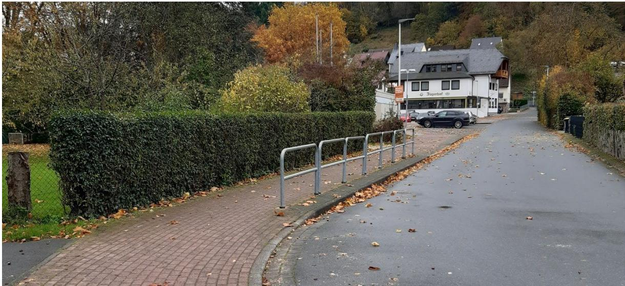
***Bild 6: Sicherung des Bürgersteigs durch Geländer***
